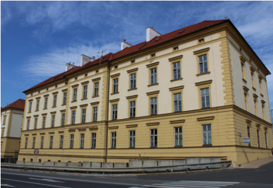
obr. 1 Budova RSZP v Levoči.
